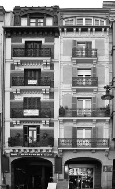
rehabilitación edificio plaza del castillo. pamplona.
